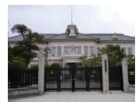
図11 津山高校旧本館
